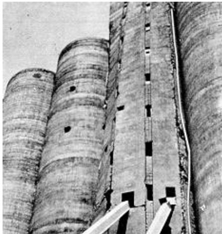
**Lérida.** Accidente por explosión en silos de diversos granos provocado por la realización de una soldadura. La explosión provocó 9 muertos, numerosos heridos y daños muy importantes a las instalaciones.
