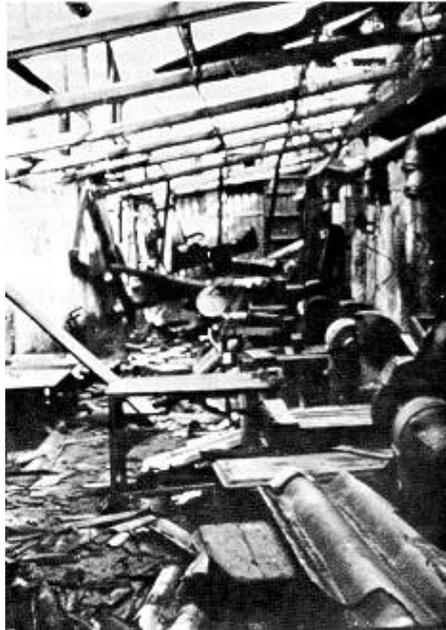
**Barcelona.** Accidente por explosión en el rectificado de cilindros de caucho. La deflagración causó quemaduras graves a uno de los operarios que falleció posteriormente.
