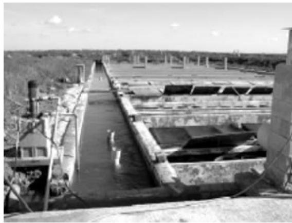
Figura 3. Instalación de engorde
